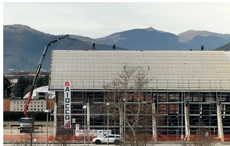
Due immagini della ristrutturazione in corso al PalaGuerrieri (foto scattate il 13 marzo 2024)
